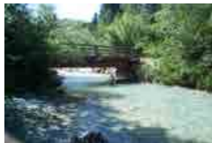
Wird ersetzt: Die alte Brücke über den Rosenbach
